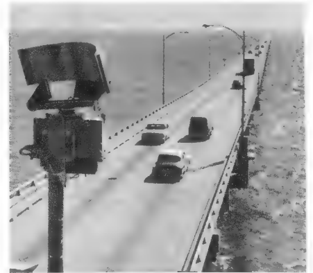
Radaranlage mit 8-Meilen-Bereich an einer der beiden Klappbrücken im Lake Pontchartrain bei New Orleans
